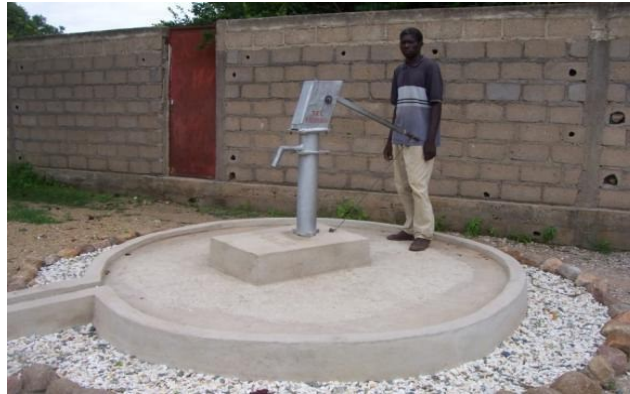
Nouveau forage à motricité humaine construit par le CEE au Lycée de Lam.
